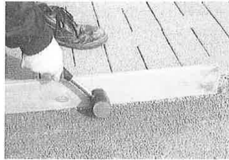
プラスチック製またはゴムハンマーでブロック目地の通りを揃えます。
