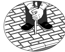
図4-2-6 ブロックの目地調整
