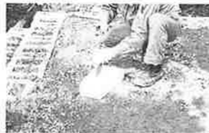
上端部の仕上げ施工
