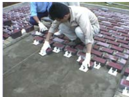
ブロックの敷設
